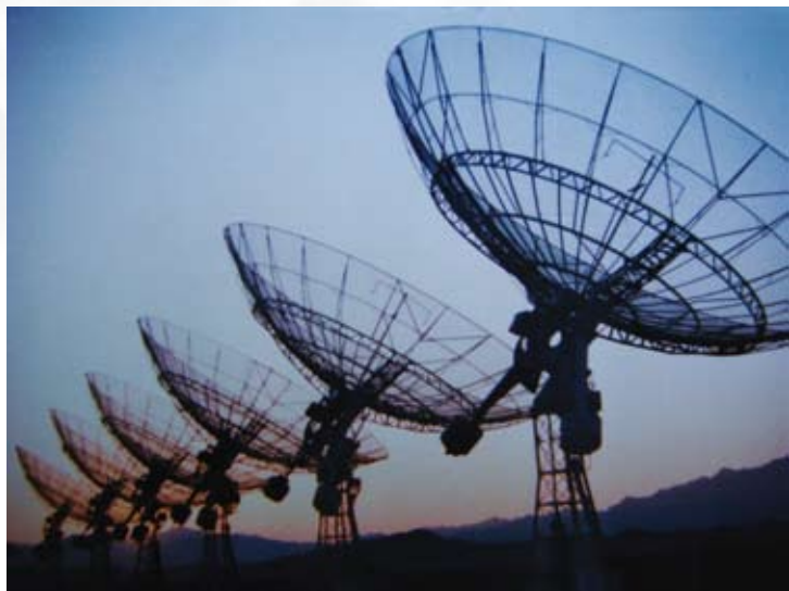
密云28面天线米波综合孔径天线阵
